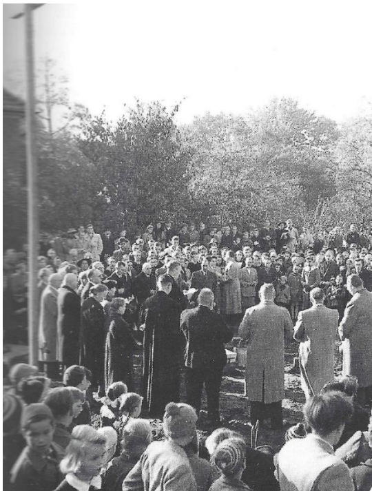
Abb. 3: Grundsteinlegung der Kirche am Rockenhof
