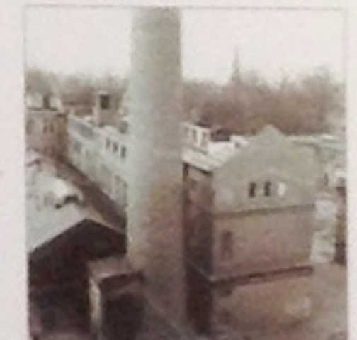
Kriegszerstörungen: Haus und Versammlungssaal „Zum Deutschen Kaiser“ und die angrenzenden Gebäude des Waschhauses und des „Hohen Wimpels“
