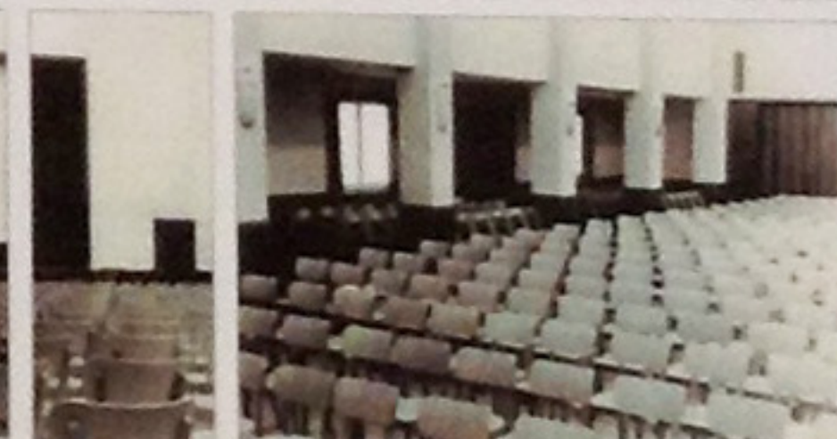
Wiederaufgebauter Versammlungssaal „Zum Deutschen Kaiser“ am 17.10.1954 vor der Wiedereröffnung
